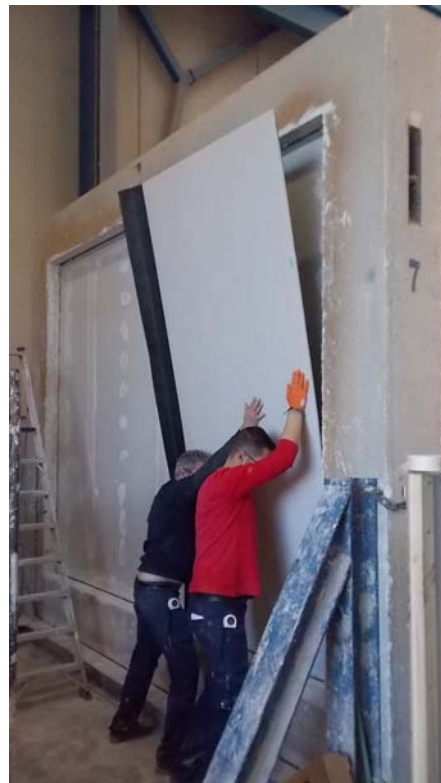
Fotos de montaje del trasdosado
